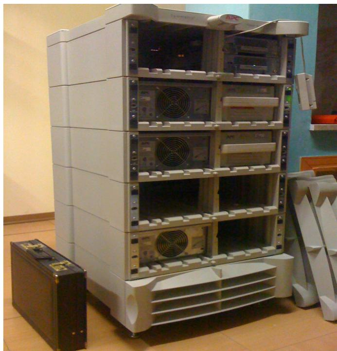
Большой ИБП, модульный, в левой колонке силовые модули и электроника, в правой колонке аккумуляторные модули.
